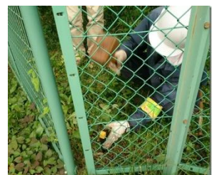
一境界線の杭打ち
