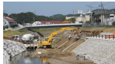
東寺方橋の前後で工事が進む
