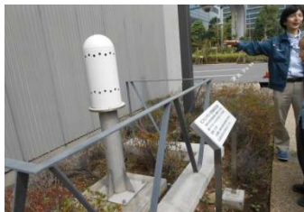
設置されたモニタリングポスト
