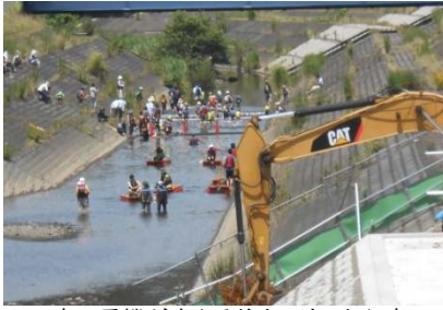
工事の重機がすぐ手前まで迫った行事
