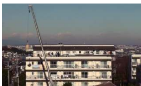
屋根貸しのパネル設置作業
