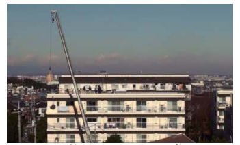
→施設への設置工事
