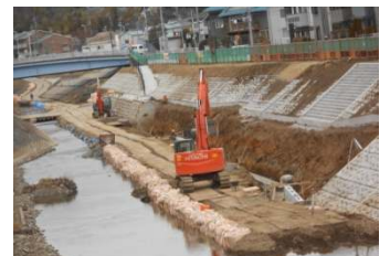
東寺方小の対岸で工事が進行中
