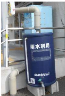
小型の貯留タンク
