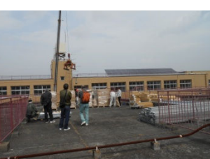
第1号発電所の屋上に資材搬入
